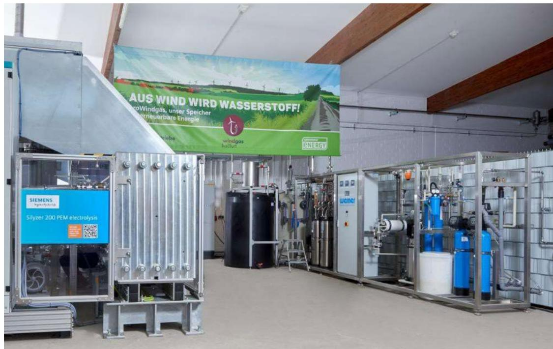
Abbildung 24: 1,25 MWel PEM-Elektrolyseur (links) mit Wasseraufbereitung (rechts) beim realen Betrieb in der Stadt Haßfurt [45]
